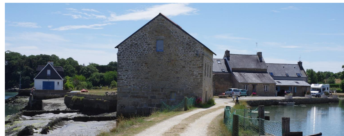
Le moulin à marée du Lac à Carnac et sa digue séparant le bassin de rétention (à droite) de la rivière de Crac'h (à gauche)
