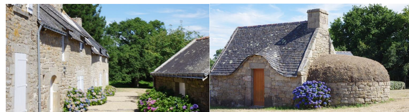
Bâtiments de ferme au lieu-dit Kerourio (Crac'h)
